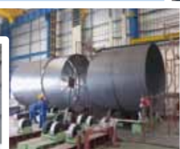
銅板組立溶接 (SS400)
